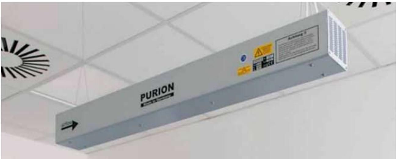
Bild 4: RLT-UVC-Anlage von Purion aus Zella-Mehlis [PUR]
